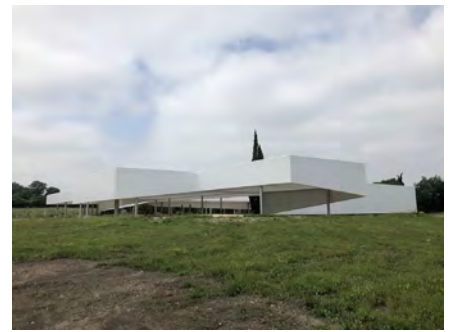
Figure 17 Villa gallo romaine de Séviac - France. Conservation et restauration des mosaïques. Réalisation de la nouvelle couverture (vue d'ensemble) (Perpignani 2019: 229).
