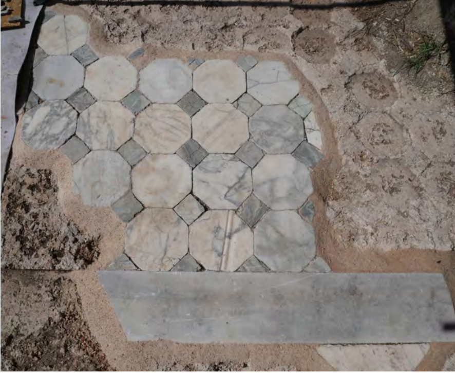
Resim 12 Kenarların harç ile sağlamlaştırılması.
