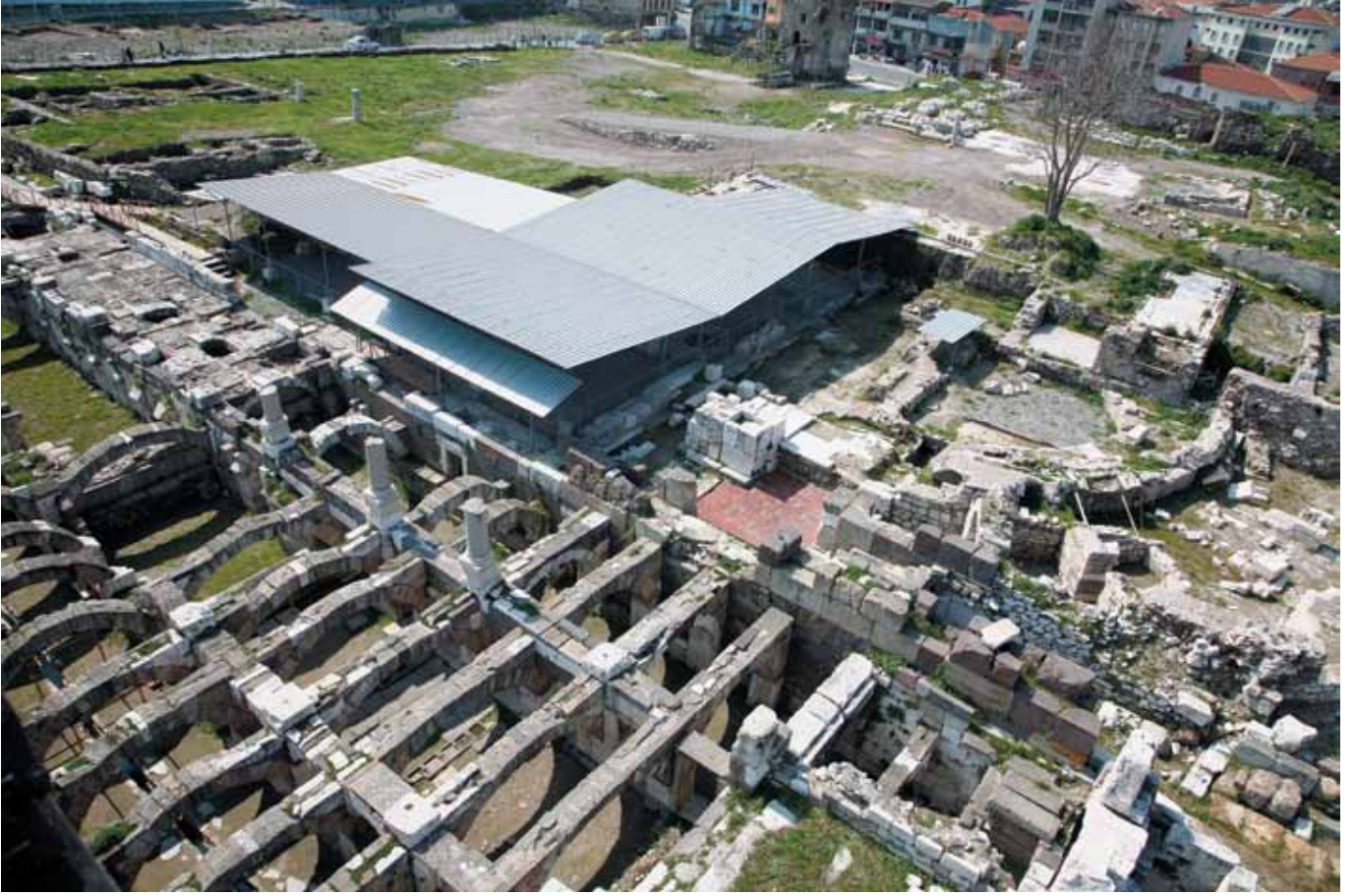
Resim 4 Modüler olarak uygulanan Mozaikli Yapı Geçici Koruma Çatısı. Sağda Bouleuterion, Altta Batı Portiko
