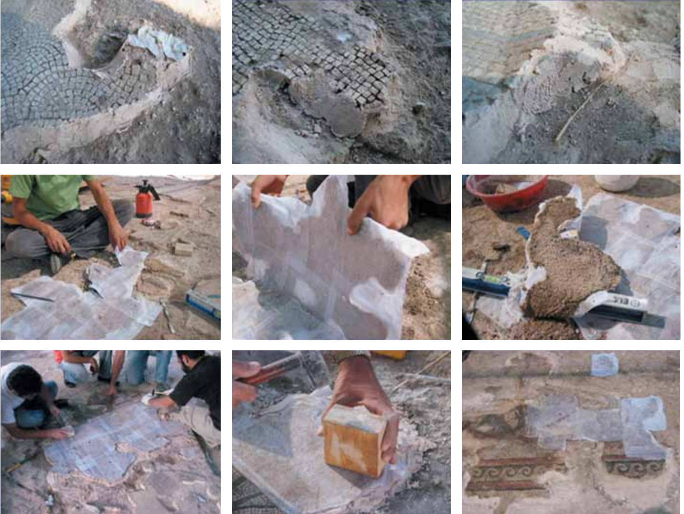
Resim 8 Yatak harcının yenilenmesi, Şanlıurfa-Haleplibahçe mozaikleri (2008)
