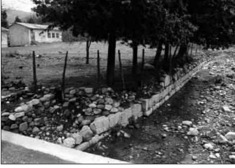
Resim 1: Bingüç mezarlık alan dıştan görünüş
