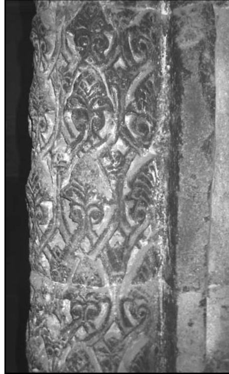
Resim 7: Erzurum Yakutiye Medresesi, portalin sađ yan kanadında aşınma ve atmosferik kirlenmeden kaynaklanan bozulma
