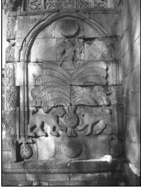
Resim 7: Erzurum Yakutiye Medresesi, portalin sađ yan kanadında aşınma ve atmosferik kirlenmeden kaynaklanan bozulma
