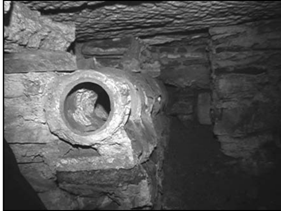
Resim 6: Yerebatan Sarnıcı yönüne uzanan su künkü
