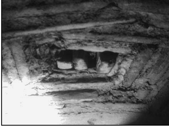
Resim 5: Tünellerde yer yer gözlenen tonoz örtü
