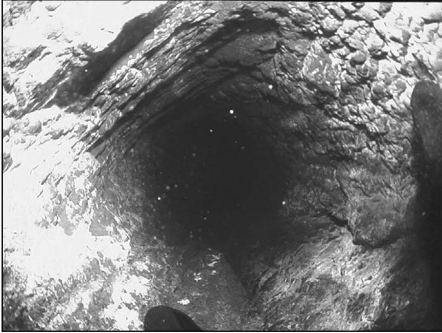
Resim 10: Kuzeybatıdaki filayağın 10,5 m. güneyindeki su dolu kuyu. Dalış sırasında çekilmiş bu fotoğraf Ayasofya'nın üzerinde oturduğu grovak oluşumunu gösterir
