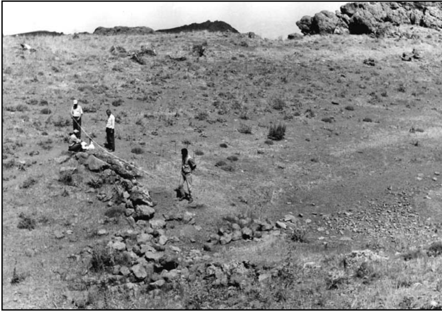
Resim 2: Tepe Göleti'nin yıkılan taş duvarları
