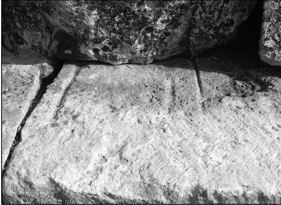
Abb. 6: Zeus-Olbios-Tempel, Säule N 11, Gusskanäle
