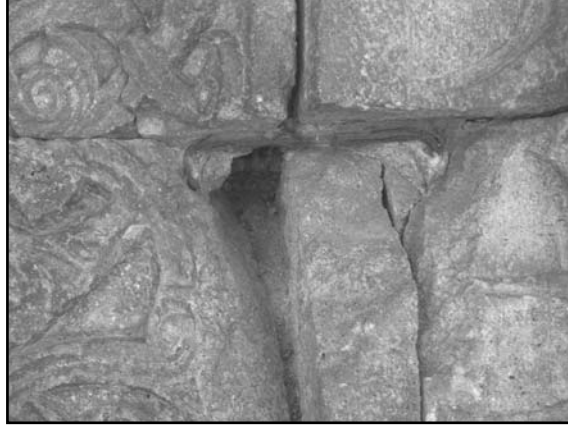
Resim 2: Erzurum Yakutiye Medresesi, portalin sađ kanadındaki kenetlerden bazıları ve bunların yol açtığı bozulmalar
