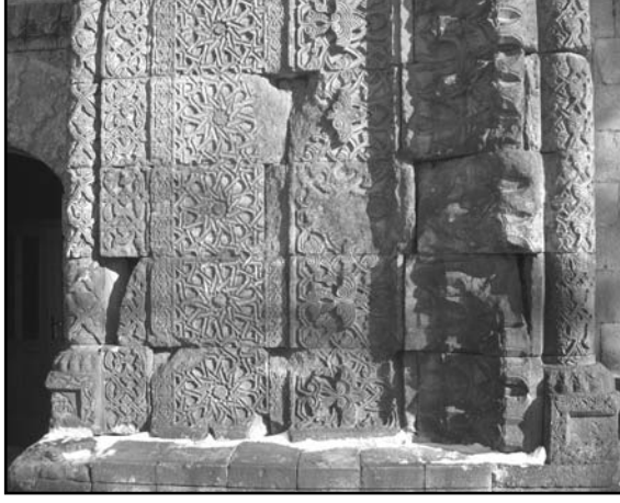
Resim 2: Erzurum Yakutiye Medresesi, portalin sađ kanadındaki kenetlerden bazıları ve bunların yol açtığı bozulmalar
