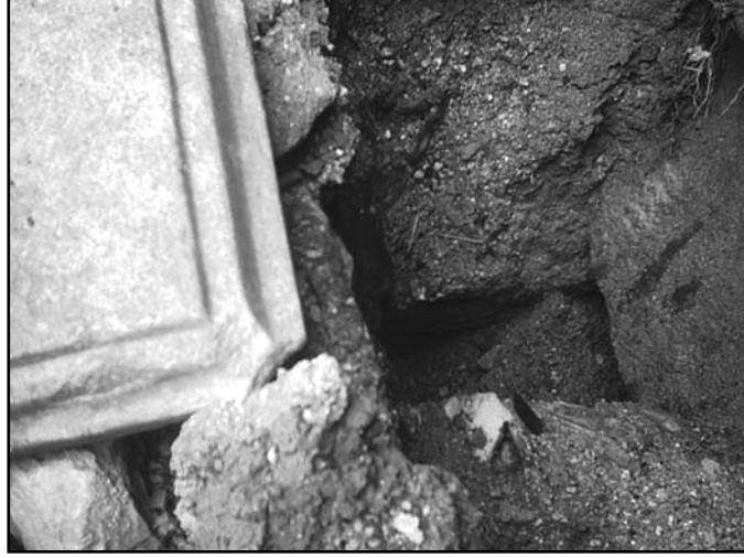
Resim 9: Ayasofya'nın kuzey bahçesindeki çökmüş tüneller
