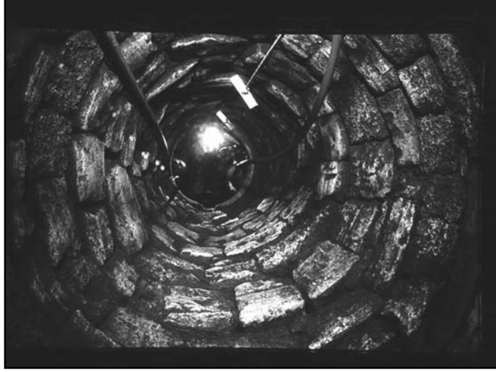
Resim 14: Kuyu, şekline göre kesilmiş kavisli kalker taştan örülmüştür
