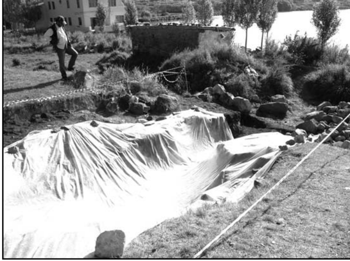
Resim 10: Çalışma alanlarının korunma çalışmaları
