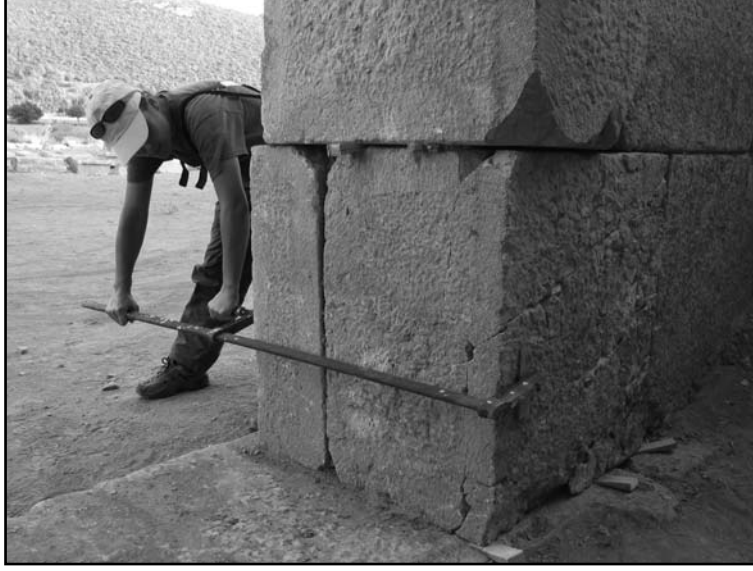
Resim 13: Meclis Binası konservasyon
