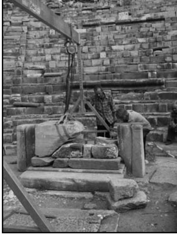
Resim 3: Sicherungsarbeiten am Theateraltar. Tiyatrodaki sağlamlaştırma çalışmaları
