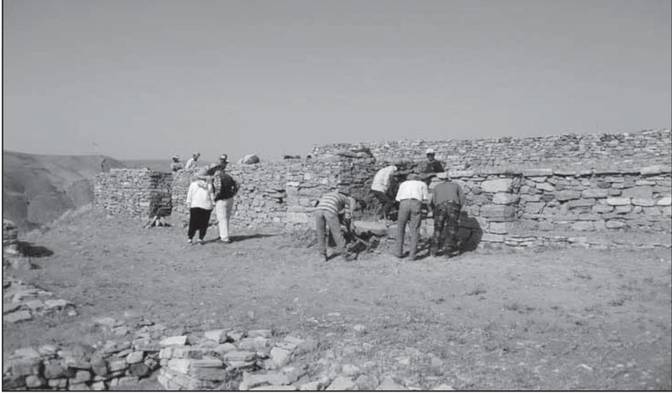
Resim 6: Saray'ın batı giriş kapısının restorasyonu.
