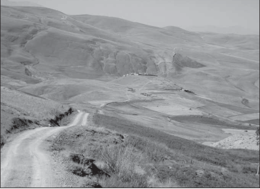
Resim 1: Yoncatepe Sarayı'nın kuzeydoğudan görünümü.
