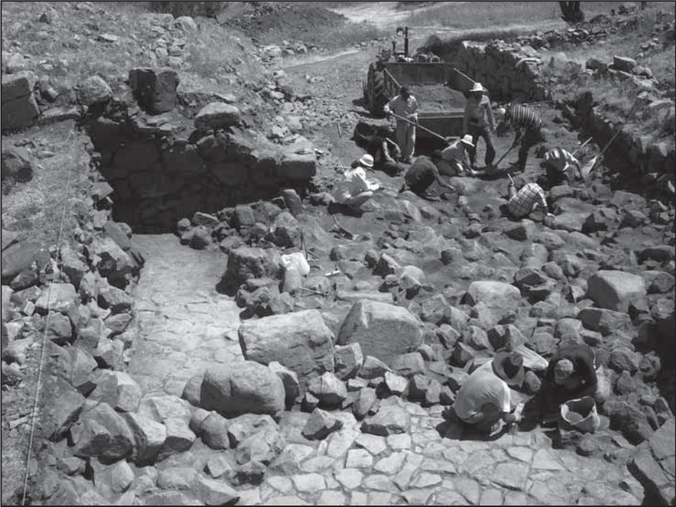
Resim 5: Kapı Geçiti ve Avlusu'na devrilen taşların temizlik çalışması. Fig. 5: Clearing collapse from the gate passage and court.
