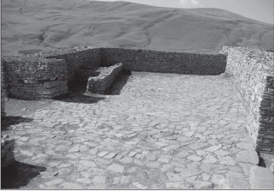
Resim 5: Saray'ın onarılan güneydoğu duvarları.
