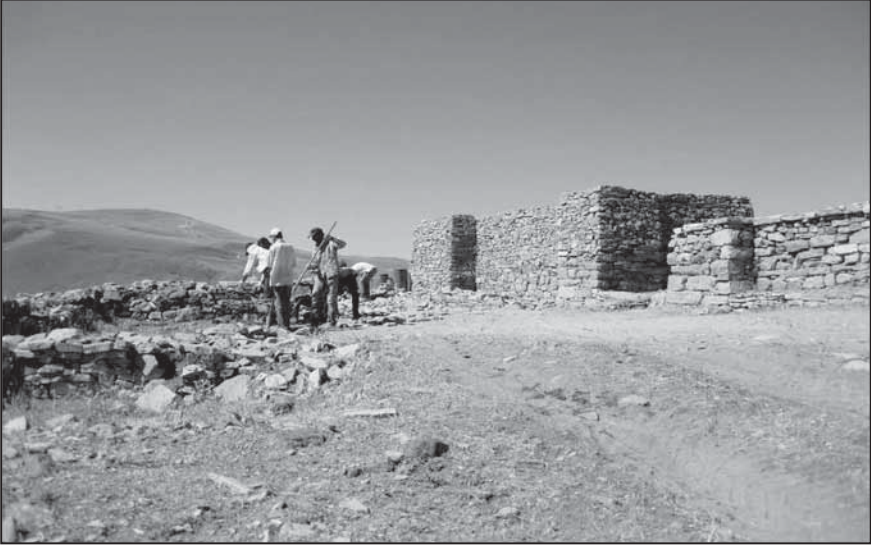
Resim 4: Saray'ın onarılan güneydoğu duvarları.
