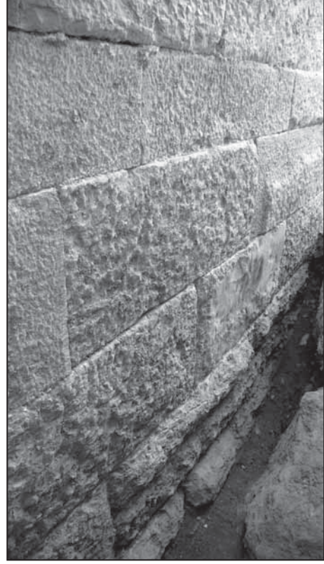
Resim 5: Çeşme Binası Doğu Duvarı, detay.
