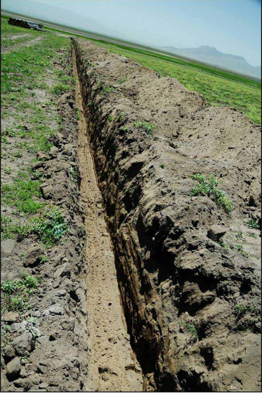
Resim 1: Doğubayazıt-Iğdır doğalgaz boru hattı kazısı
