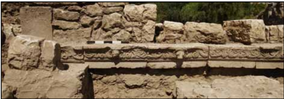
Abb. 4: Theaterthermen, Spolienblöcke in der Südmauer
