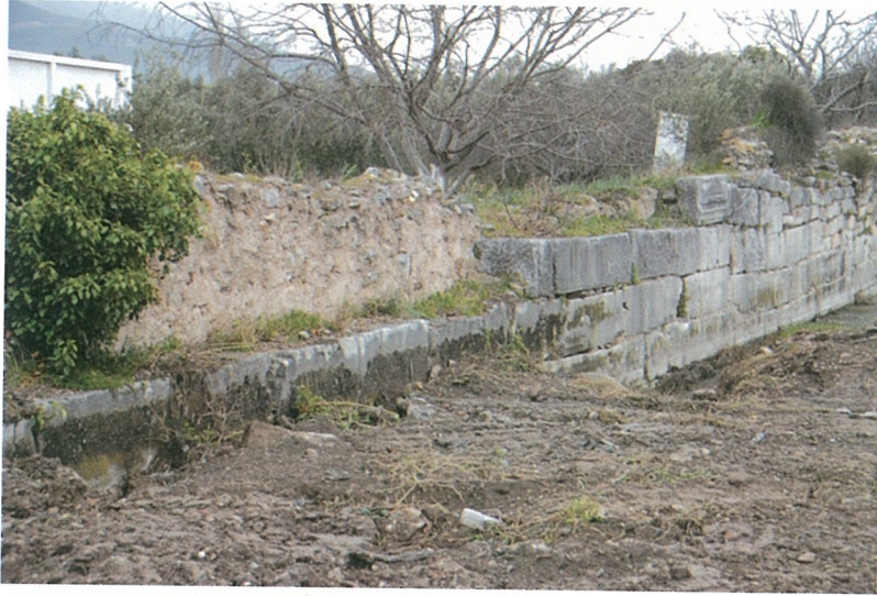
Resim 4. Duvarın güney yanına giydirilen taş kaplama.
