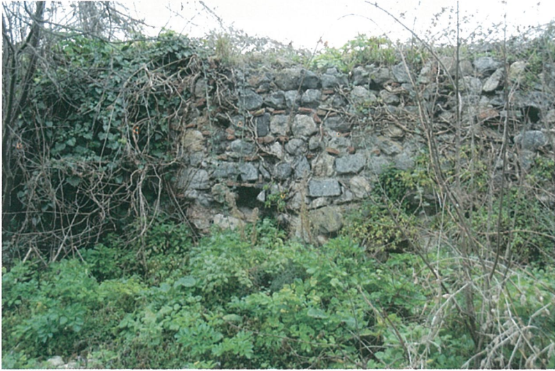
Resim 6. Duvarın kaba bırakılan yüzeyinde tuğla ile yapılan çerçeve.
