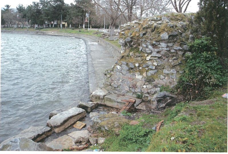
Resim 19. Platform temel duvarları sur duvarından gelen duvarla birleşmekte.
