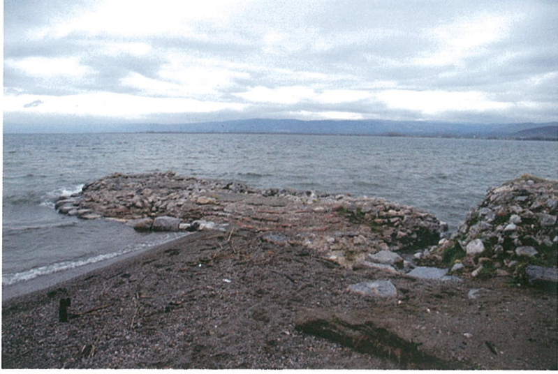
Resim 15. Platform üzerinde yer alan kanal burada zaman içerisinde büyüme olduğunu akla getirmekte.
