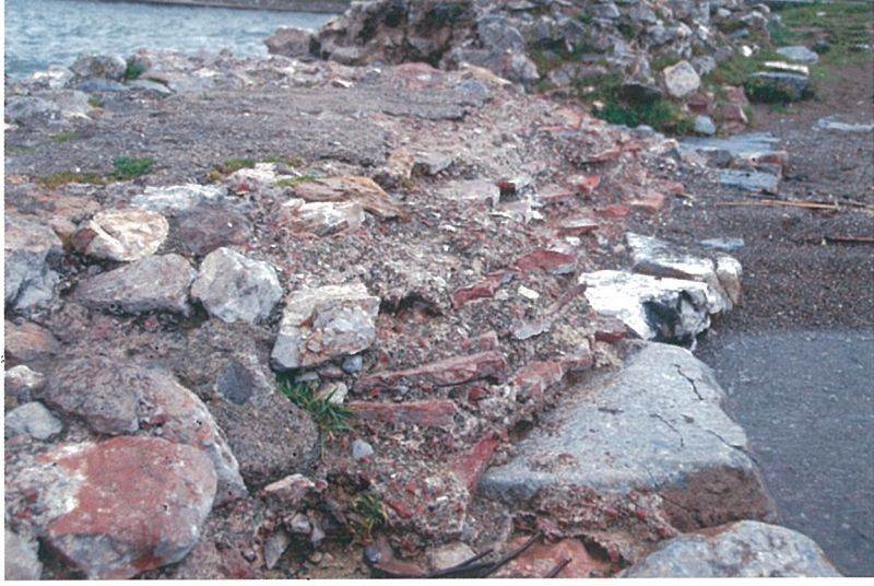
Resim 13. Platformdan detay. Alttaki dikdörtgen kesilmiş taş bloklardan temel, bunun üzerinde kare şeklindeki tuğla sırası ve en üstte de horasan harçlı moloz taşlardan blokaj.
