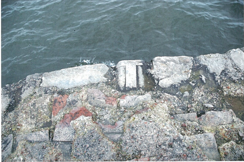
Resim 14. Alt yapıda kullanılan devşirme mazlemeler arasında Bizans çağına özgü çift yarım sütunlar da bulunmaktadır.
