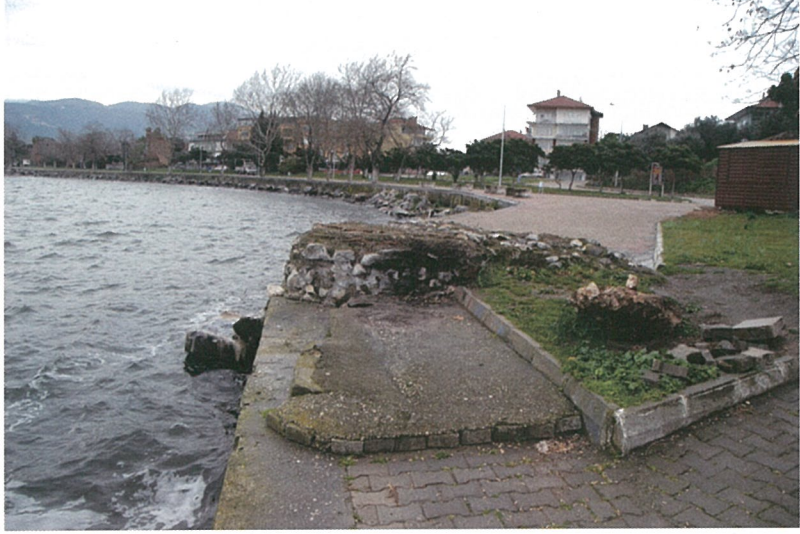
Resim 21. Göl Kapının kuzeyinde göl kenarında in-situ duvar ve taş temele ait bloklar.
