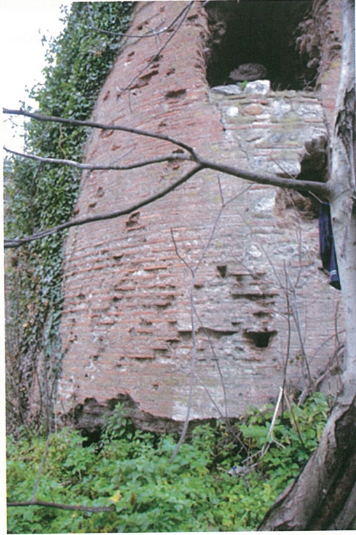
Resim 10. Duvarın bitiminde yer alan tuğladan örülmüş kule. Orta hattaki renk farklılığı burada bir birleşmeye işaret etmektedir.
